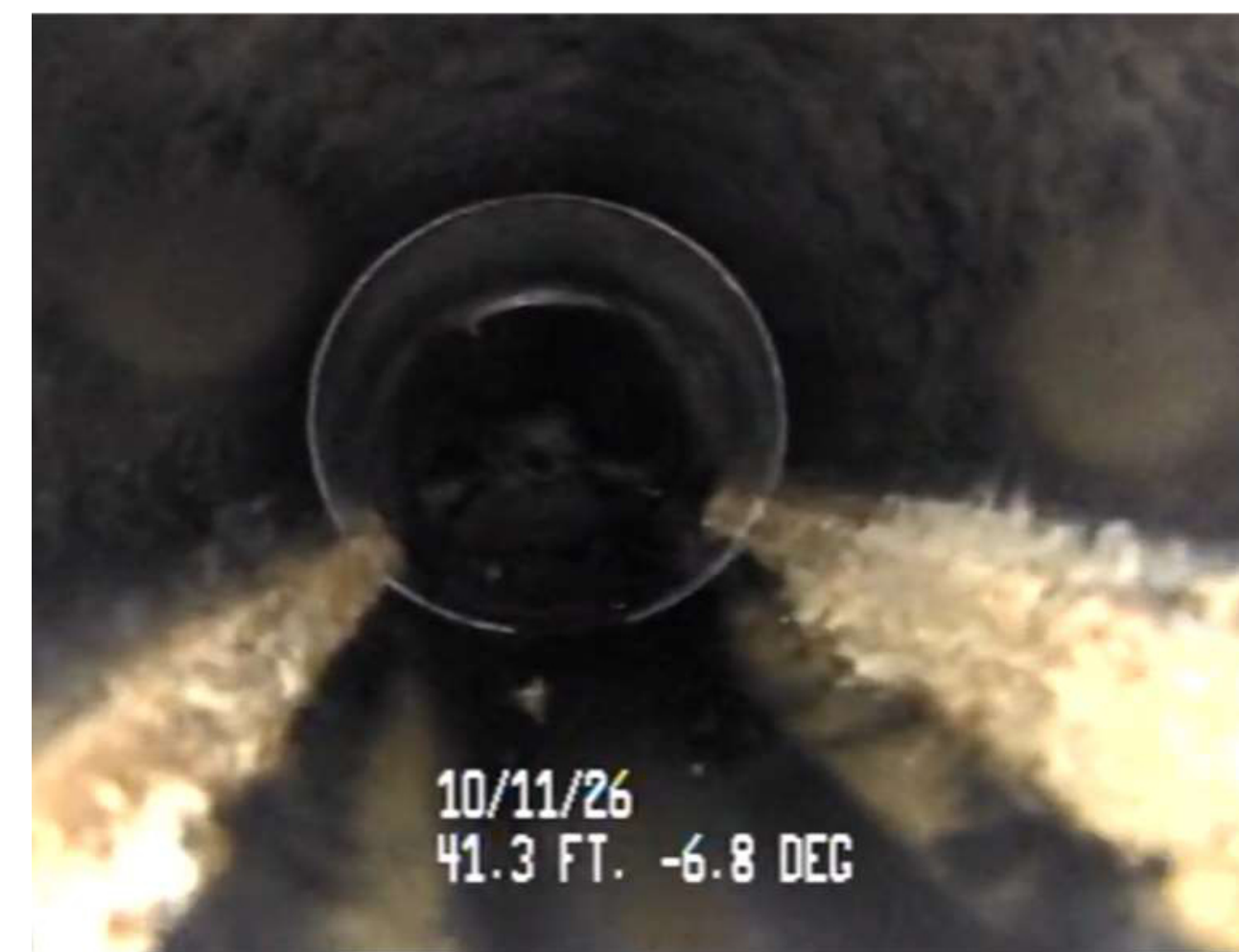
Ống Hiện Có với Dầu Bôi Trơn Giữa MH119-120
