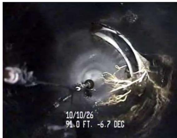
Grieta de tubería existente y raíz entre MH 90-92
