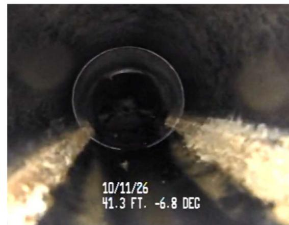
Tubería existente con grasa entre MH119-120
