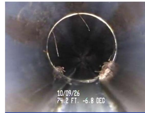
Junta de raíz existente entre MH 127-128
