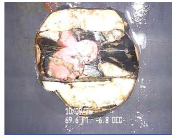
Daño superficial a tubería ex. entre MH 125-126
